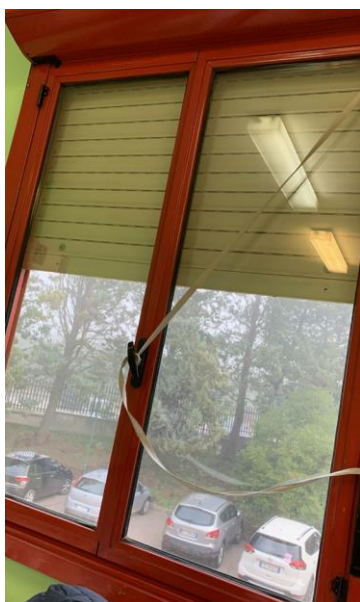
Presenza di finestre battenti e dunque non a norma in tutte le classi, sia in sede succursale che centrale. Molte di esse hanno le tapparelle rotte. Nell'ultima foto a destra, la finestra è addirittura "chiusa" con lo scotch.
