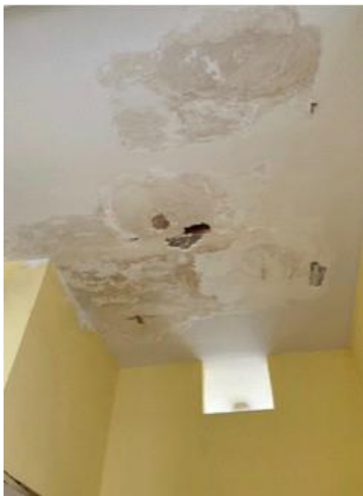
Infiltrazioni d'acqua nel corridoio del quinto piano della sede di Via Calandra, e luci fulminate.
