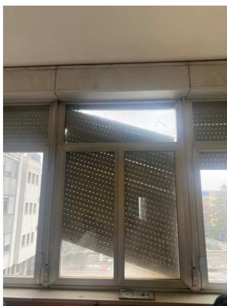
Presenza di finestre battenti e dunque non a norma in tutte le classi, sia in sede succursale che centrale. Molte di esse hanno le tapparelle rotte. Nell'ultima foto a destra, la finestra è addirittura "chiusa" con lo scotch.
