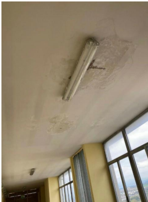
Infiltrazioni d'acqua nel corridoio del quinto piano della sede di Via Calandra, e luci fulminate.
