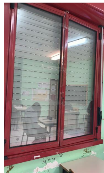
Presenza di finestre battenti e dunque non a norma in tutte le classi, sia in sede succursale che centrale. Molte di esse hanno le tapparelle rotte. Nell'ultima foto a destra, la finestra è addirittura "chiusa" con lo scotch.
